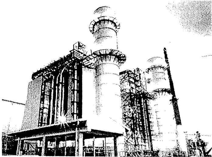
รอขยาย - โครงการโรงไฟฟ้าพลังความร้อนร่วมจะนะ ชุดที่ 2 จ.สงขลา เป็นหนึ่งในแผนที่มีการไฟฟ้าฝ่ายผลิตแห่งประเทศไทย จะต้องก่อสร้างเพื่อเพิ่มกำลังผลิตไฟเข้าระบบปี2557 เพิ่มอีก 800 เมกะวัตต์
